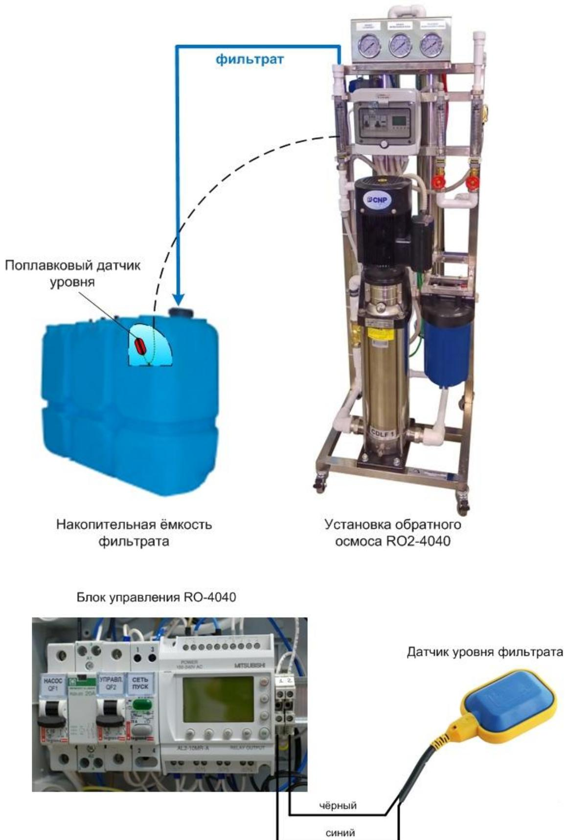
Рис. 5 Подключение одного датчика уровня к установке.
