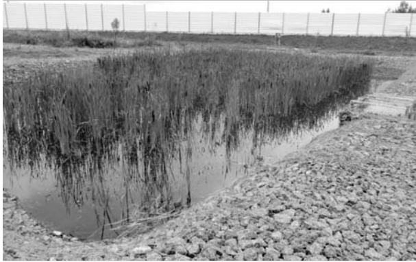
Рисунок 8 – Гидроботаническая площадка, засаженная высшей водной растительностью
