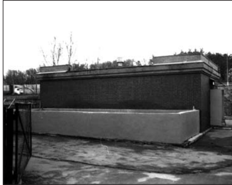
Рисунок 13 – Очистное сооружение индивидуального проектирования
