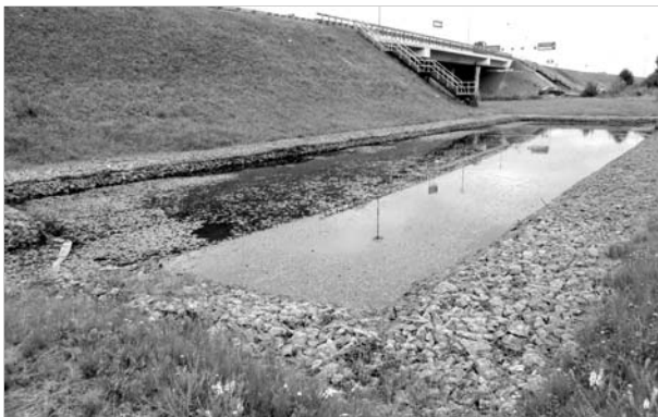
Рисунок 7 – Гидробиотическая площадка с устройством плавающих бонов из сорбирующего нефтепродукты материала
