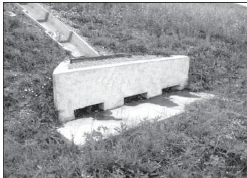
Рисунок 22 – Простейшее очистное сооружение со щебеночной загрузкой
