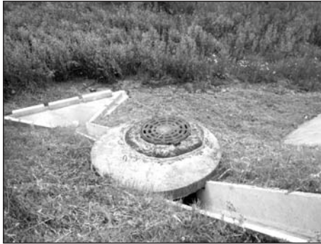
Рисунок 24 – Простейшее очистное сооружение типа «усовершенствованный водоприемный колодец»
