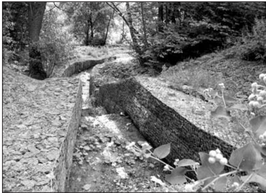
Рисунок 25 – Лоток сброса очищенных стоков на рельеф местности, выполненный с использованием габионов
