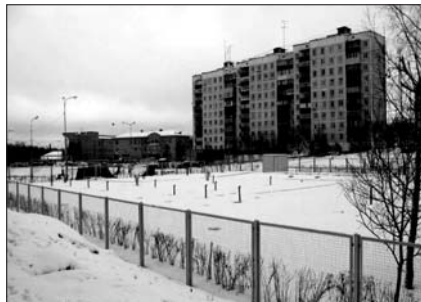
Рисунок 11 – Общий вид сборных очистных сооружений модульного типа подземного расположения
