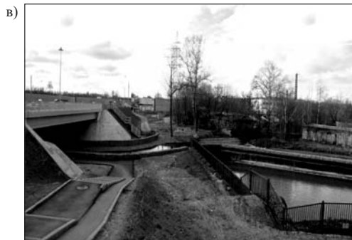
Рисунок 3 – Пруды-отстойники с использованием габионов каскадного типа (а, б) и сбросом в реку (в)
