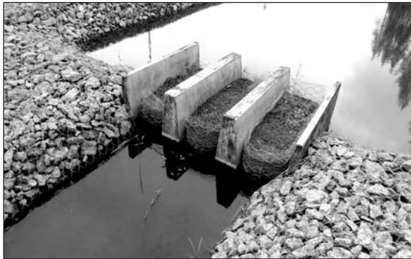
Рисунок 9 – Фильтрующая кассета с загрузкой природным сорбентом
