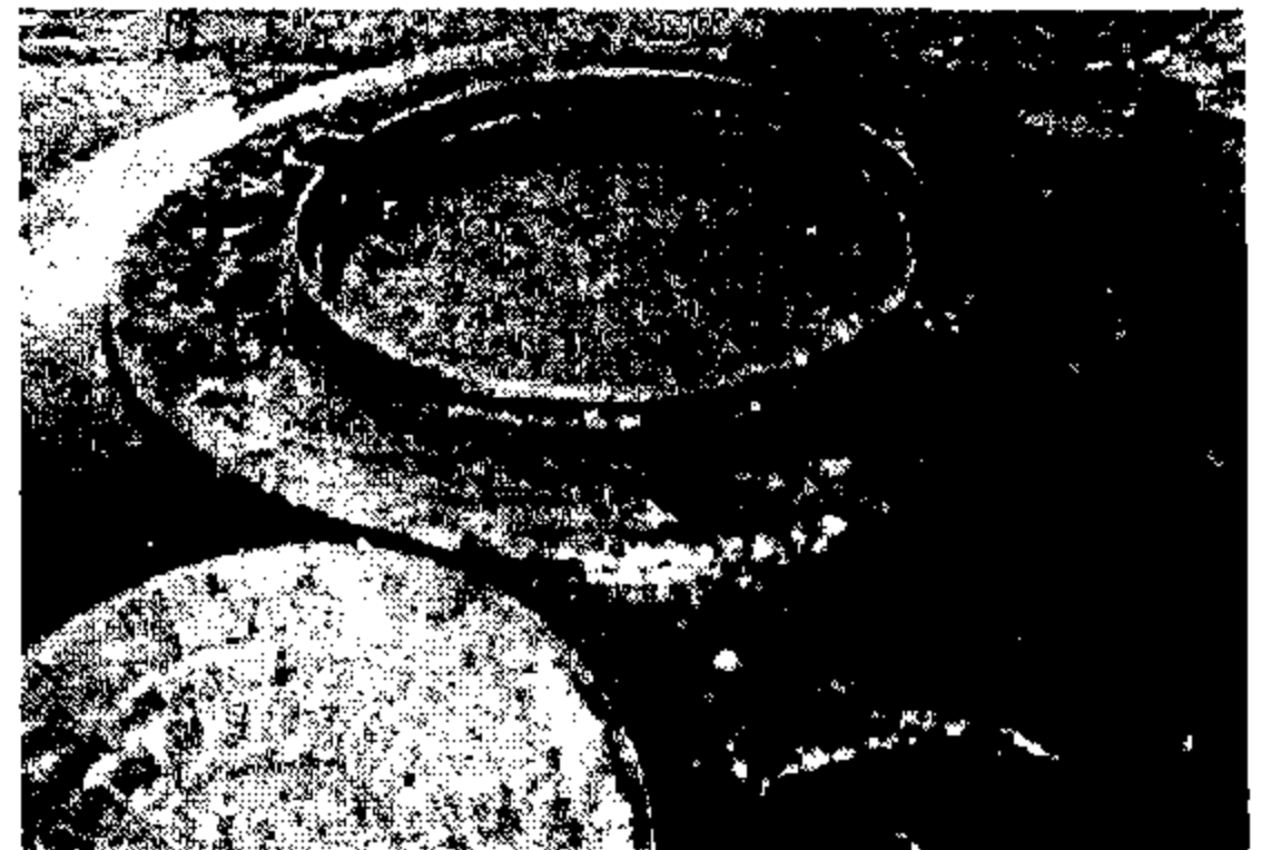
Рис. 6.10. Опорная железобетонная плита для горловин смотровых колодцев
