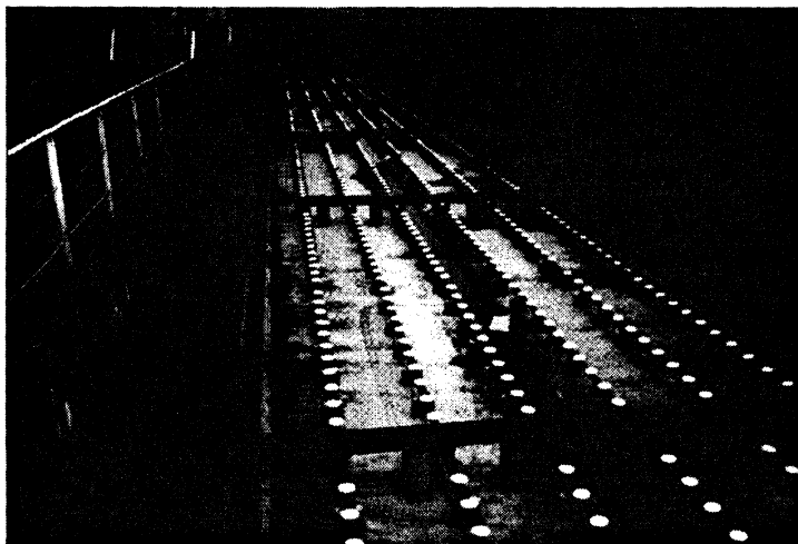
Рис. 12.19. Общий вид аэрационной системы с тарельчатыми диффузорами
