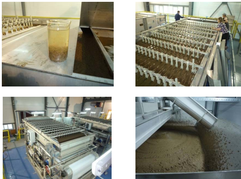
Рис. 3. Образующийся осадок на ленточных сгустителях СГ-22 и ленточных фильтр-прессах ПЛ-16К
