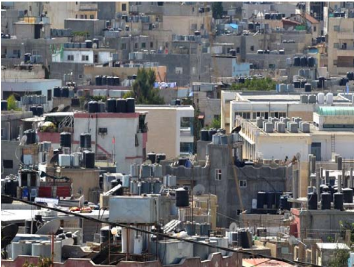
Рис. 2. Водяные цистерны для хранения воды, устанавливаемые палестинскими жителями на крышах домов
