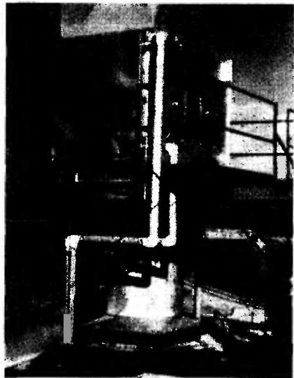
**Рис. 39.33** Теплота топочных газов передается питательной воде в экономайзере и, кроме того, возможна рекуперация теплоты путем подогрева воздуха для горения. Пучок труб теплообменника (справа) установлен в дымовой трубе (слева). (публикация с разрешения General Resource Corporation.)
