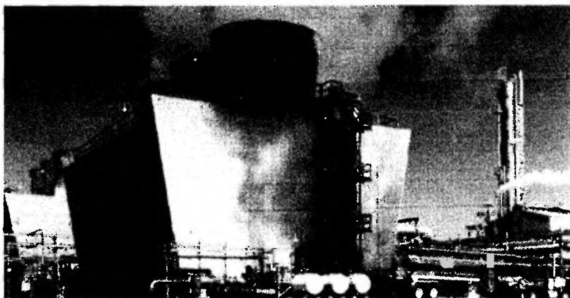
**Рис. 38.12** Конструкция градирни с отсасывающим вентилятором. Забор воздуха происходит через вентиляционные решетки градирни, затем воздух распределяется по всей градирне и сбрасывается в атмосферу в верхней ее части.
