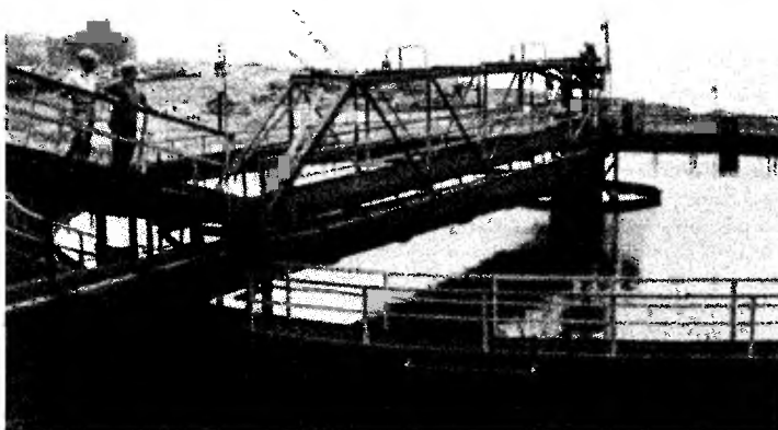
Рис. 32.4 Конструкция отстойника-сгустителя, применяемого для очистки сточных вод из системы мокрой очистки отходящего газа доменной печи с целью удаления и утилизации твердых веществ. (Фотография предоставлена Inland Steel Company.)
