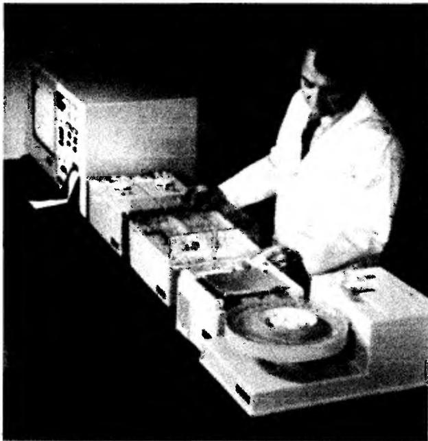
Рис. 7.38. Автоматическое устройство для мокрого анализа целого ряда проб (фотография предоставлена Technicon Instruments Corporation).
