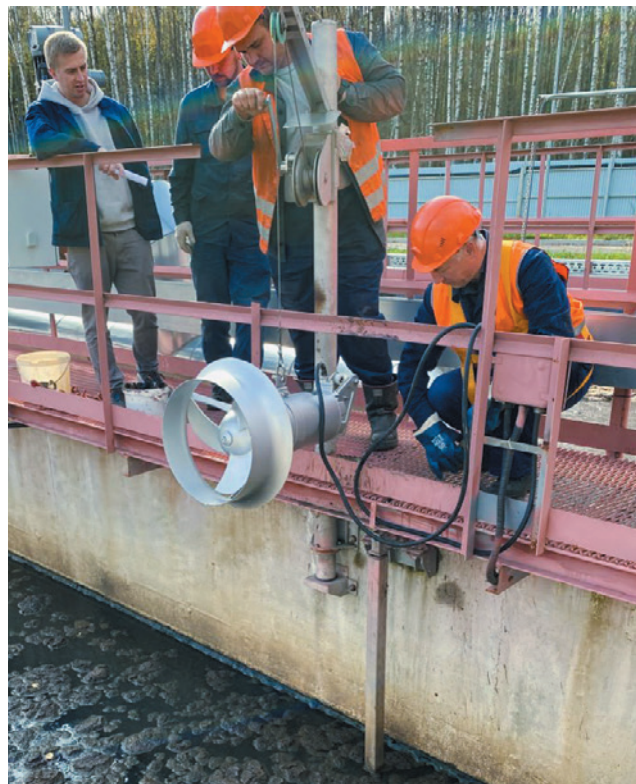
Монтаж погружной мешалки AIKON QJB2,5/8-400/3-740/S
