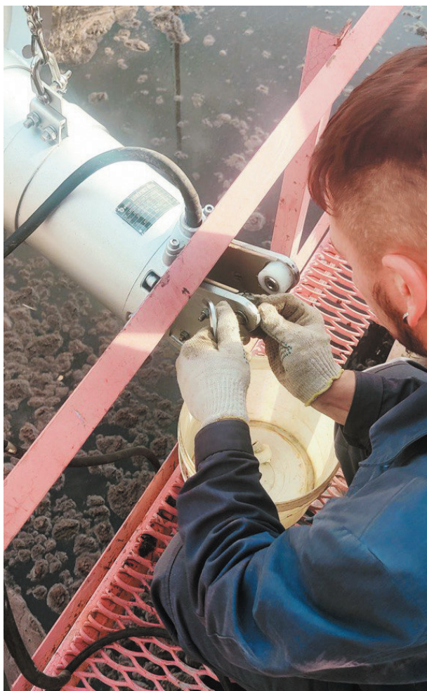
Монтаж направляющих роликов мешалки AIKON QJB2
