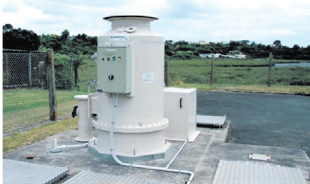
Рис. 4. Адсорбер на станции перекачки в г. Отуманга (Новая Зеландия). Расход воздуха: 1300 м 3 /ч
