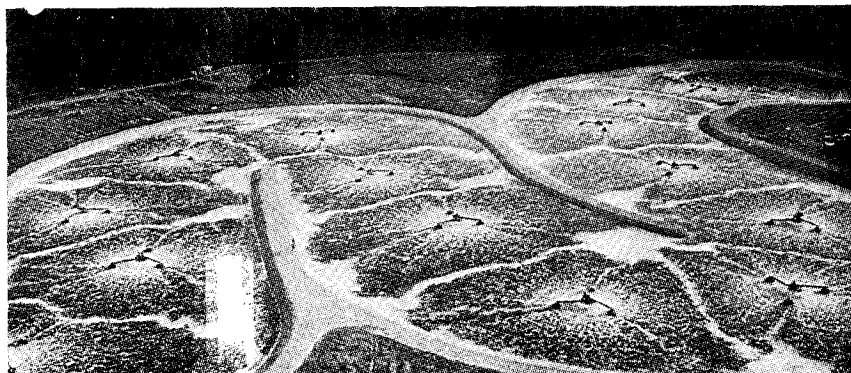
Рис. 25.9. Аэрируемые лагуны для обработки сточных вод целлюлозно-бумажного производства. Целлюлозно-бумажное предприятие «Оребро Фровифор» (Швеция)
