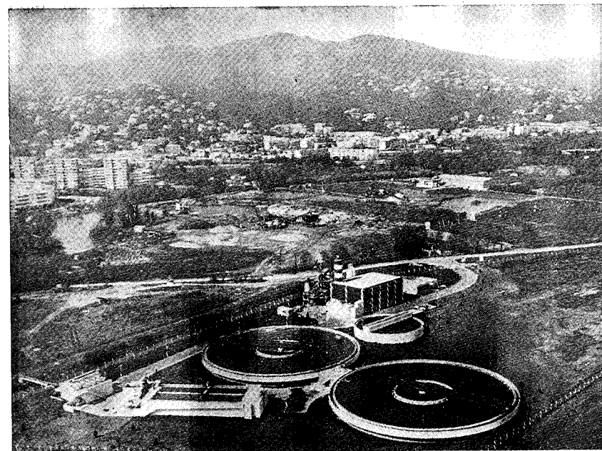
Рис. 24.33. Вид на очистные сооружения в Канне (Франция), включающие предварительную очистку, флокуляцию, отстаивание и обработку осадка. Станция обслуживает 153 000 чел. зимой и 225 000 чел. летом
