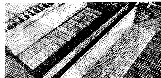
Рис. 9.30. Фильтры «Аквазер» типа Т в процессе монтажа (слева направо: поддерживающие элементы, днище из бетонных плит, и днище, оборудованное колпачками)
